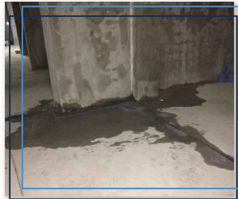
Протечки по деформационным швам
